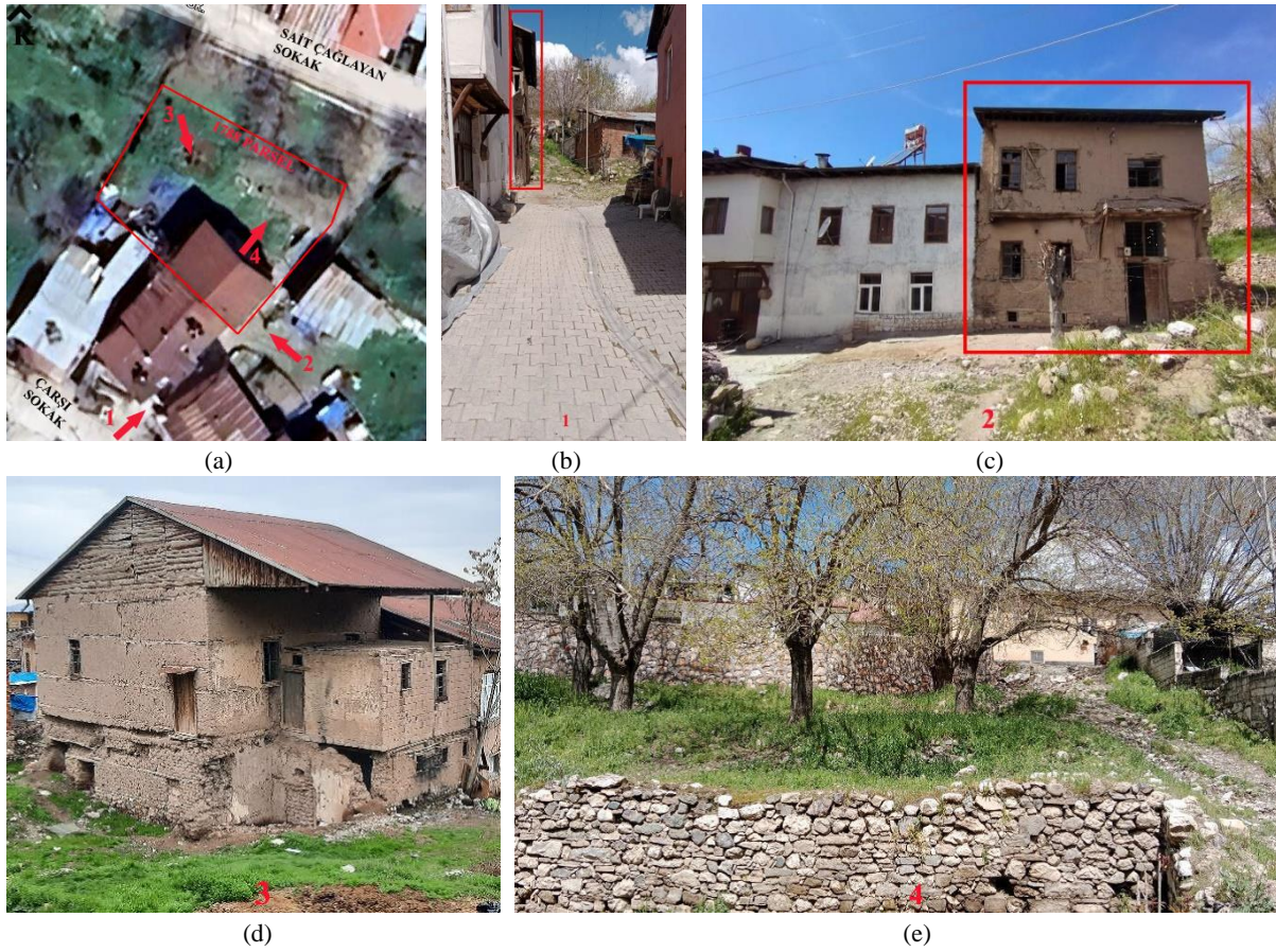
Şekil 8: 23 No'lu konutun çevresinden çekilen fotoğrafların bakış yönleri (a), Çarşı Sokak'tan görünüm (b), ana giriş (c), bahçeden görünüm (d) ve bahçedeki duvar kalıntısı (e)
