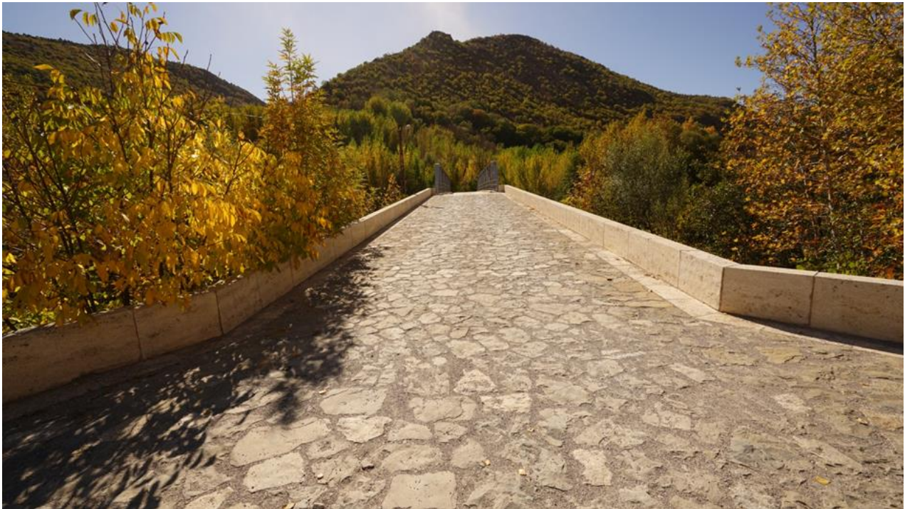
Resim 13. Kozluk Köprüsü, Döşeme (Cumali Levent, Arapgir2021).
